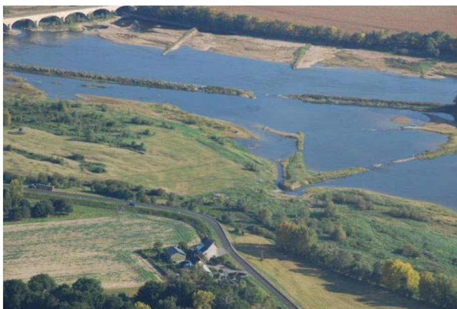
Epis en aval immédiat de la chevrette de l'Alleud
