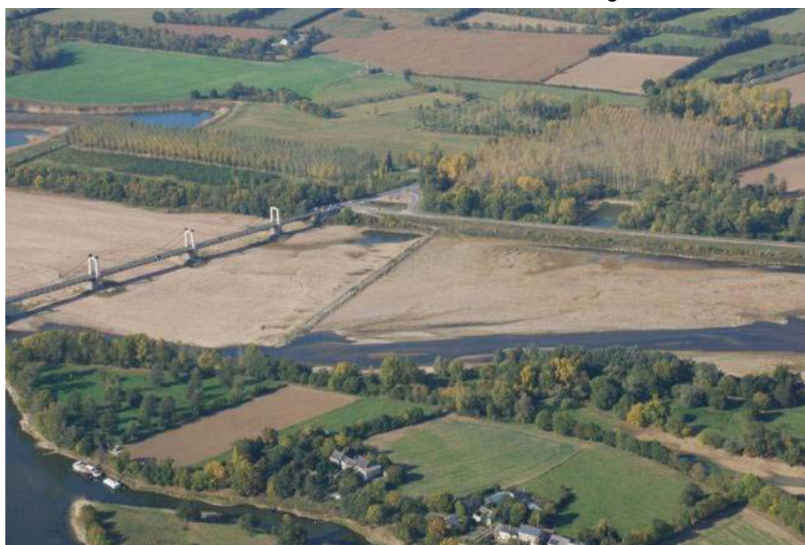
Epis traversant en aval du bras de Saint-Georges
