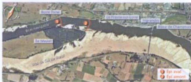
Le site, en aval du Fresne-sur-Loire.
