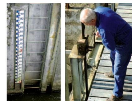
Des éclusiers (salariés ou membres de syndicats) assurent les manœuvres des ouvrages hydrauliques. Pour mesurer et ajuster les niveaux d'eau, ils disposent de repères ou de cotes. Dans certains marais, comme en Sud Loire ou côté Brivet, les principales vannes ont des sondes et capteurs de niveau. En Nord Loire, elles sont équipées de simples échelles limnimétriques depuis 2010.
