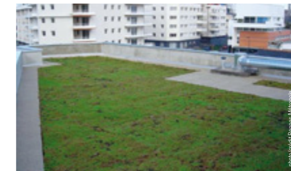
Toiture végétalisée ZAC Saint-Hélier Rennes Métropole
