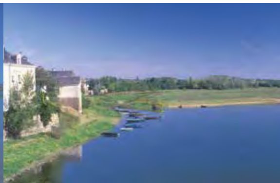
Amont du Pont d'Ingrandes à 200 m³/s
