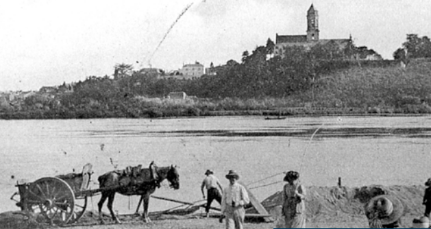
Exploitation du sable sur les grèves de Loire à la Meilleraie, face à Saint-Florent-le-Vieil (49), en 1905
