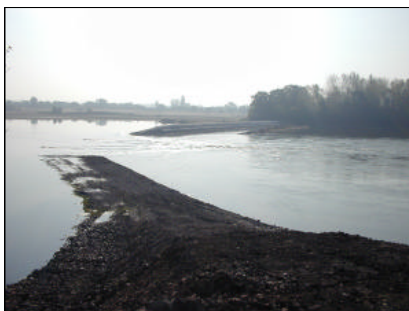
Photo 12 : Vue de l'ouvrage en construction
