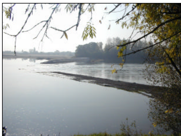
Photo 11 : Vue de l'ouvrage en construction
