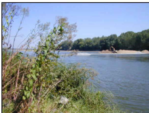
Photo 4 : Vue de l'ouvrage en construction
