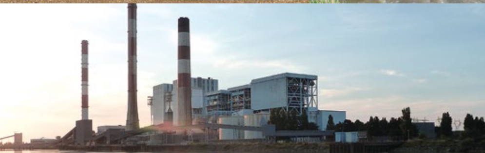
Centrale thermique de Cordemais (44), prélevant et rejetant de l'eau en Loire
